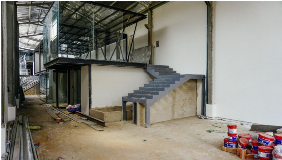
Hình 1.2 Minh họa hiện trạng xây dựng công trình 5
